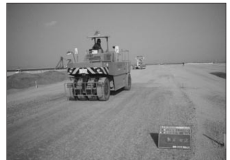
タイヤローラー転圧状況
