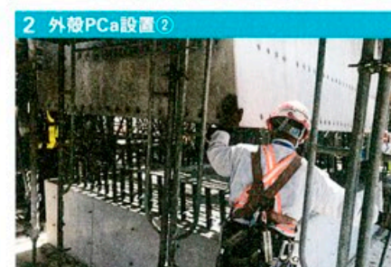
1 外殻PCa設置① 2 外殻PCa設置② 3 クリーンクリート打設 4 ガーダー架構完成
