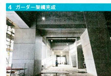
1 外殻PCa設置① 2 外殻PCa設置② 3 クリーンクリート打設 4 ガーダー架構完成
