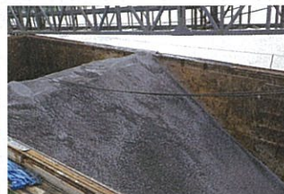
写真右が地盤改良用鉄鋼スラグ。これを2018年2月から4月にかけて写真のサンドコンパクション船で海底地盤に圧入した。サンドコンパクションパイルの径は2000mm、ピッチは2100mm。砂で428本を造成した後、鉄鋼スラグで1601本を造成した
