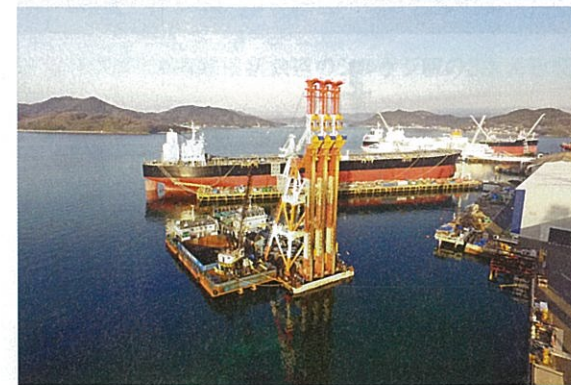
写真右が地盤改良用鉄鋼スラグ。これを2018年2月から4月にかけて写真のサンドコンパクション船で海底地盤に圧入した。サンドコンパクションパイルの径は2000mm、ピッチは2100mm。砂で428本を造成した後、鉄鋼スラグで1601本を造成した
