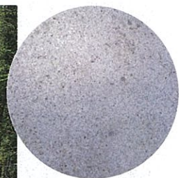
林業専用道は作設指針に基づき設計されるもので、10t積み程度のトラックや林業用車両の走行を想定する。補修や除草など維持管理コストの縮減が求められる。写真右上は、大洞林道(林業専用道)完成後の路面
