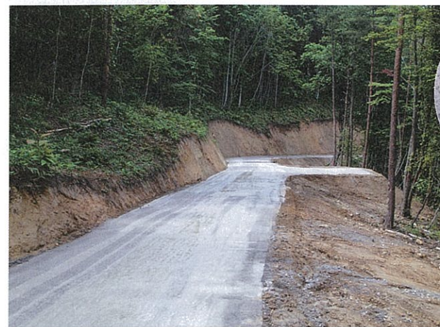
林業専用道は作設指針に基づき設計されるもので、10t積み程度のトラックや林業用車両の走行を想定する。補修や除草など維持管理コストの縮減が求められる。写真右上は、大洞林道(林業専用道)完成後の路面
