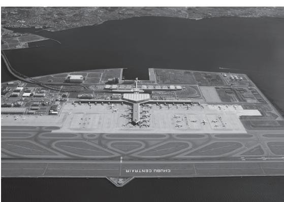
中部国際空港セントレア用地造成工事(2001~2004年)では、滑走路・誘導路の路盤、エプロン(駐機場)の路床材などに、約190万トンの鉄鋼スラグ製品が使用された。
