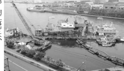
名古屋港東海元浜埠頭の工事の様子。圧送船で混合し打設できる(上)。打設後は強度な地盤を形成できる(下)
