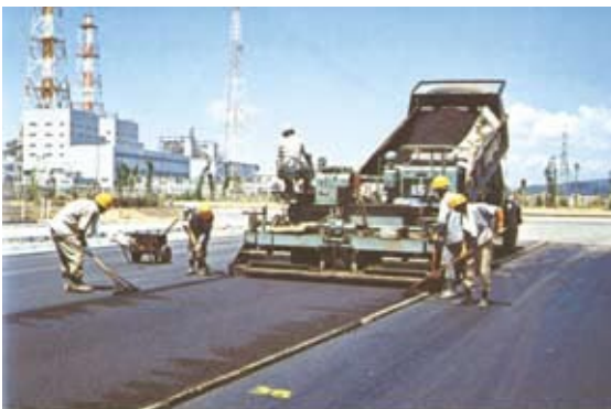
▲アスファルト舗装
