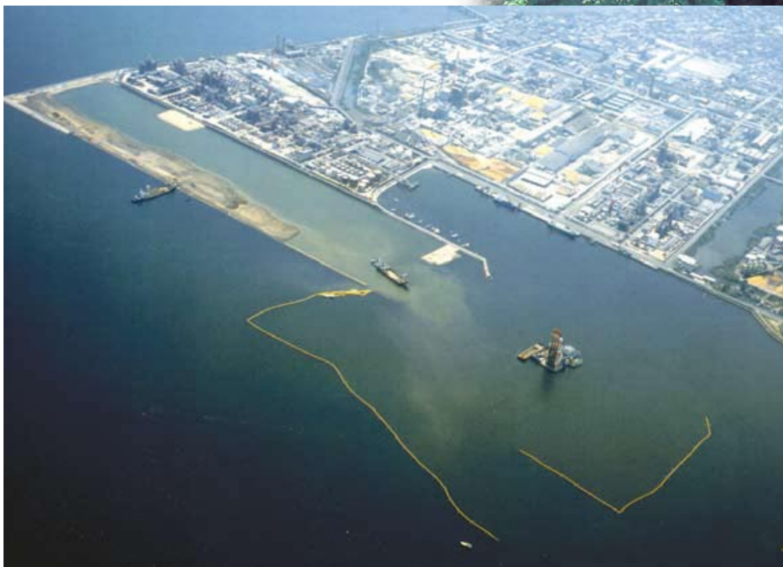
▲製鋼スラグ製品を用いたSCP(サンドコンパクションパイル)工法による地盤改良(広島県大竹港)
