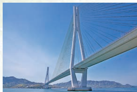
6 多々羅大橋(広島県-愛媛県)〈1999年〉
