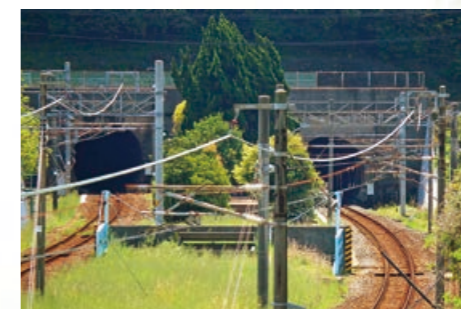
14 関門鉄道トンネル(山口県-福岡県)〈1942年〉
