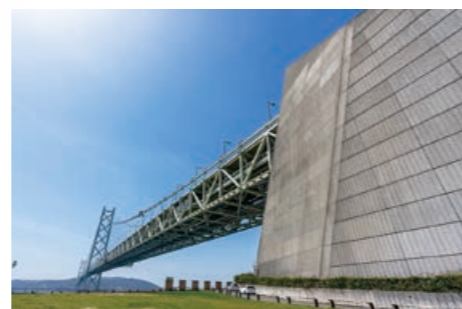
5 明石海峡大橋(兵庫県)〈1998年〉
