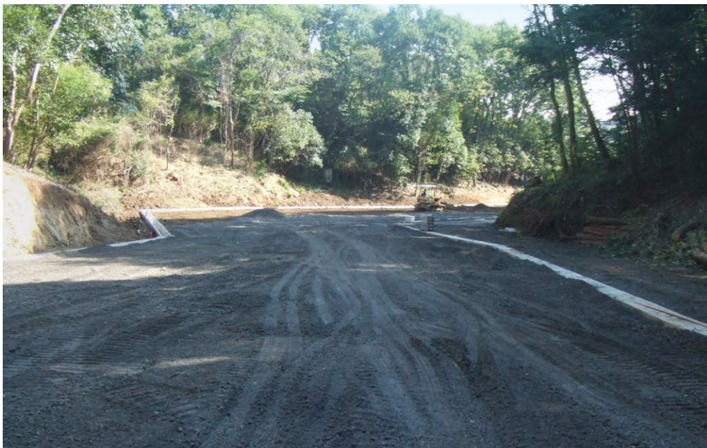
施工例（未舗装道路：埼玉県児玉郡神川町）
