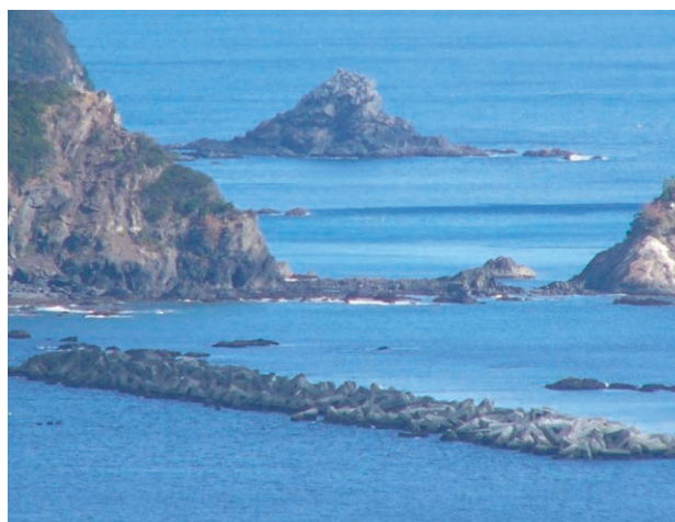
消波ブロック（三重県南伊勢町） 〔粗骨材に EFG を 50% 混合〕
