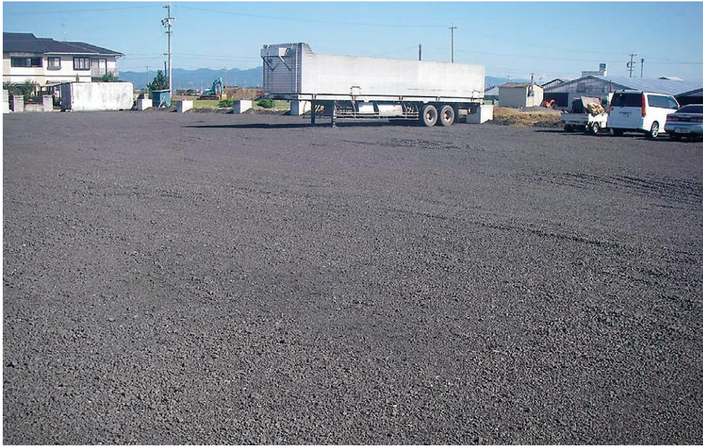
施工例（駐車場整地：愛知県豊橋市）
