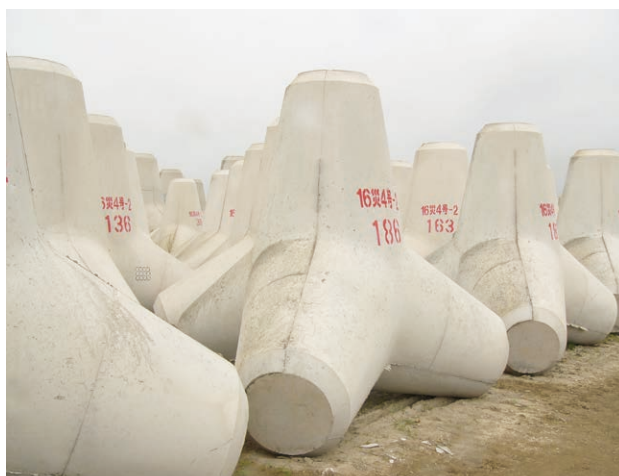
消波ブロック（福井港） 〔細骨材にEFSを100% 使用〕
