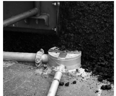
下部基台周辺のアスファルト舗装
