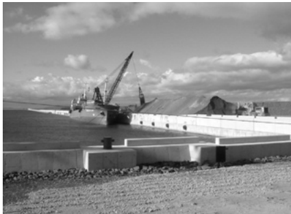
CS 材の空港島陸揚げ
