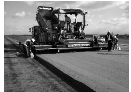
滑走路の下層路盤材 (CS セメント安定処理)
