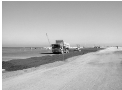
滑走路の路床整正盛土 (CS 材)
