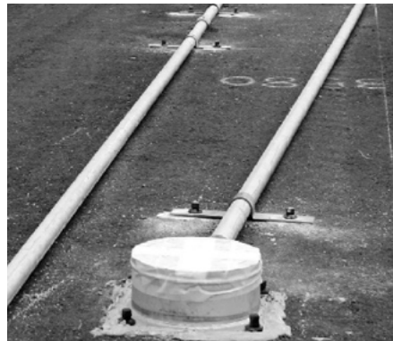
下部基台・配管固定状況
