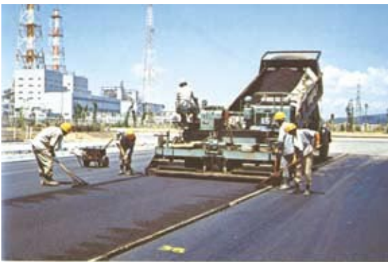
▲アスファルト舗装
