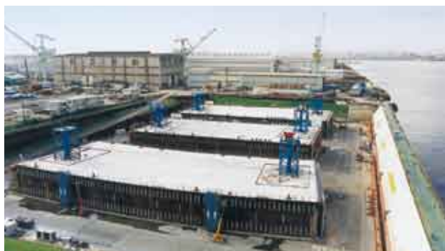
▲神戸港港島トンネル沈埋函
