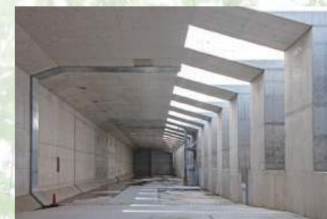
15 東京外環自動車道（千葉県）〈2018年〉
