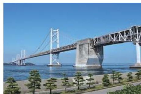
7 南北備讃瀬戸大橋（香川県）〈1988年〉
