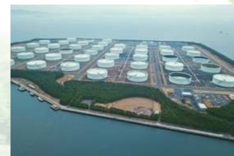
18 志布志石油備蓄基地（鹿児島県）〈1992年〉
