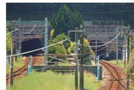
14 関門鉄道トンネル（山口県-福岡県）〈1942年〉
