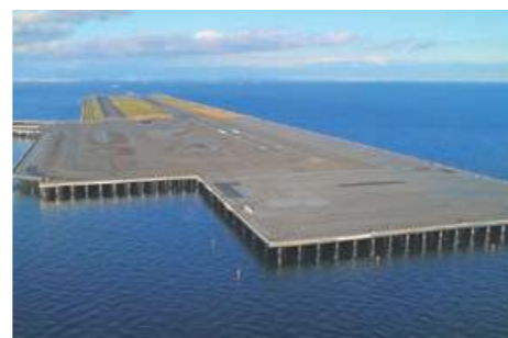
16 東京国際空港D滑走路建設工事（東京都）〈2010年〉
