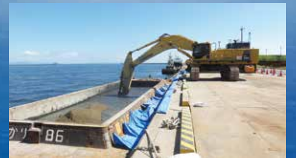
浚渫土にカルシア改質材を混ぜている様子
