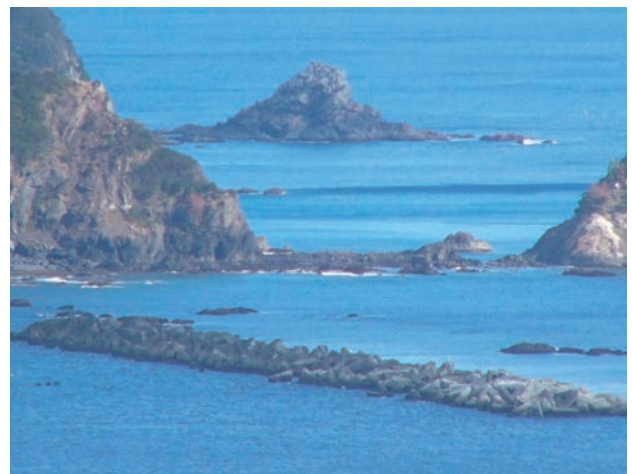
消波ブロック（三重県南伊勢町） 〔粗骨材に EFG を 50% 混合〕
