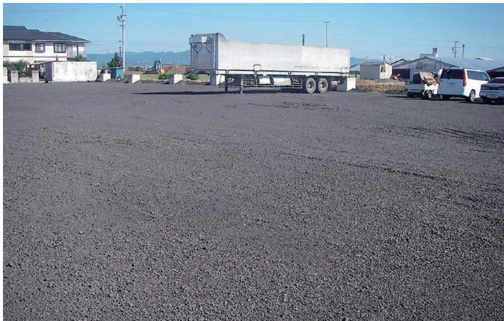
施工例（駐車場整地：愛知県豊橋市）
