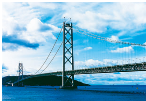
高炉セメントが使用された明石海峡大橋
