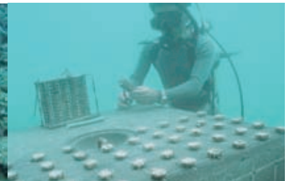
写真5/サンゴの幼生がついた着床具をマリブロックに埋め込む
