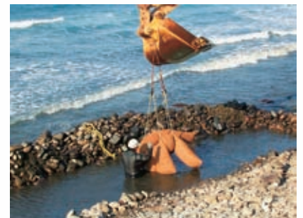
写真1 / 2004年北海道増毛町の海岸にビバリーユニットを設置
