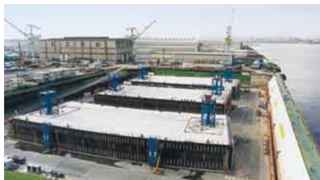
▲神戸港港島トンネル沈埋函
