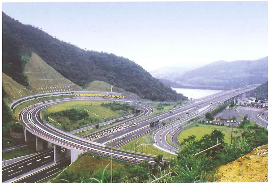
▲山陽自動車道姫路東ランプ
