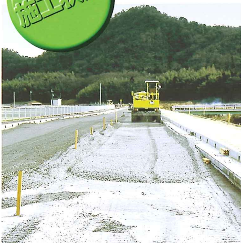
▲県道広畑港臨港道路工事
