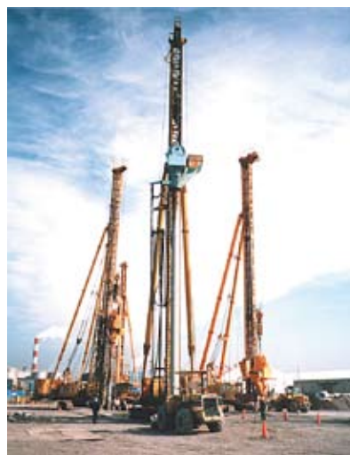
陸上SCP施工状況
