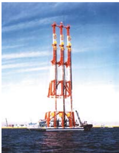
海上SCP施工状況
