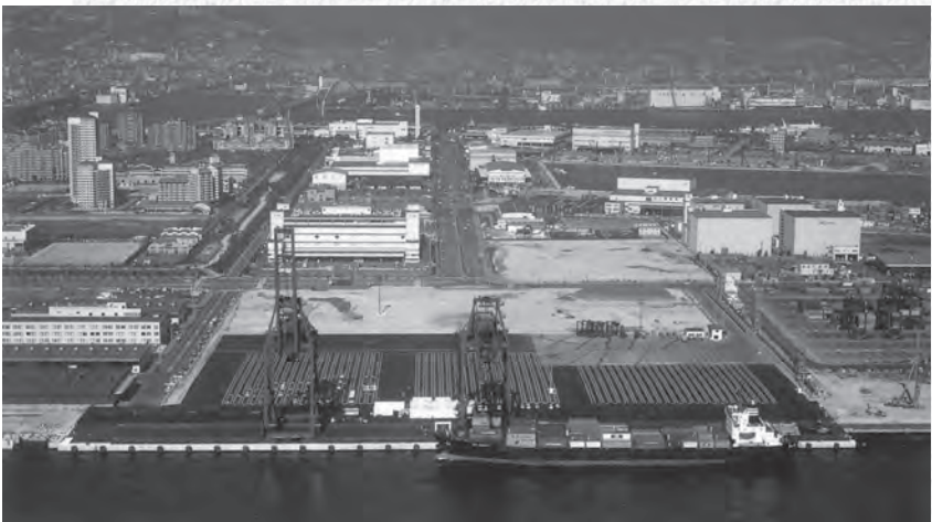
現在の神戸港六甲アイランド。復旧にはスラグ製品が使われた（図1参照。写真提供/鉄鋼スラグ協会）。
