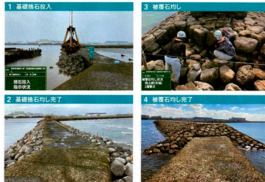
1 基礎捨石の投入指示。基礎捨石の重さは1個当たり100~200kg。作業員が立っている場所が補修工事前の防泥柵。この防泥柵を石積みで台形状に巻き込むことで老朽化した柵の機能回復を図る 2 基礎捨石の投入作業と均し作業を終えた段階。基礎捨石を固定するため、この上にさらに被覆石をかぶせていく 3 被覆石の均し作業 4 被覆石の均し作業を終えた段階。天端高A.P.+3.1mを確保する
