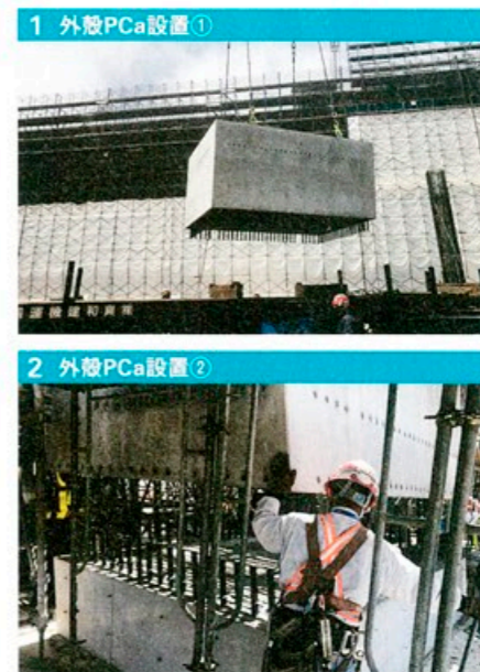
1 外殻PCa設置① 2 外殻PCa設置② 3 クリーンクリート打設 4 ガーダー架構完成
