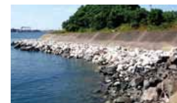
護岸根固め用の石材として使用
