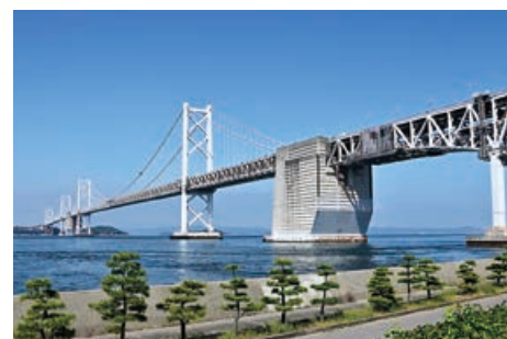
7 南北備讃瀬戸大橋(香川県)〈1988年〉
