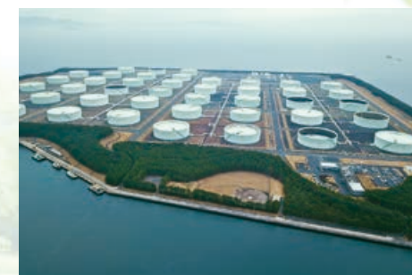
18 志布志石油備蓄基地(鹿児島県)〈1992年〉
