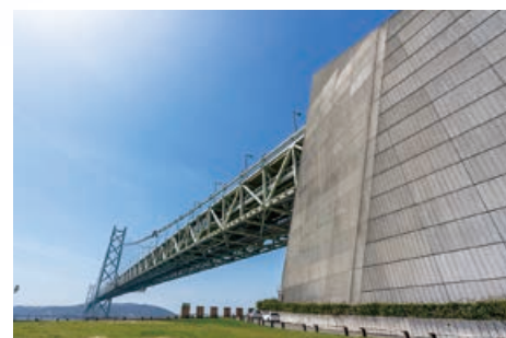
5 明石海峡大橋(兵庫県)〈1998年〉
