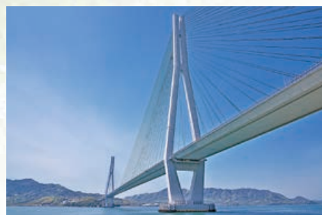
6 多々羅大橋(広島県-愛媛県)〈1999年〉
