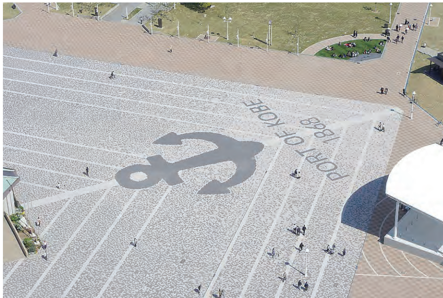
神戸港メリケンパークで敷き詰められたインターロッキングブロック（高炉スラグ細骨材）
