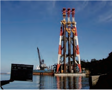
海上SCP施工状況
