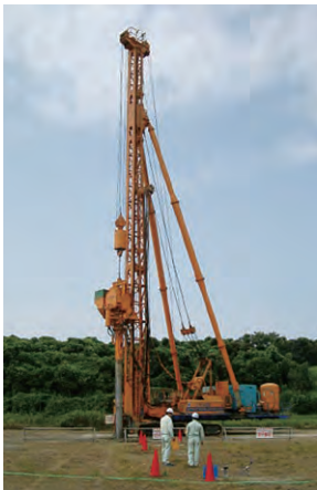
陸上SCP施工状況
